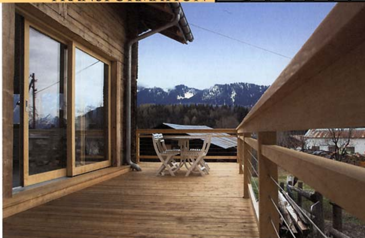
La galerie couverte originelle en façade ouest a laissé la place à une vaste terrasse communiquant avec le living par une baie vitrée ouvrante de trois mètres sur deux. Le balcon de la façade nord a été conservé en remplaçant simplement les éléments pourris.
