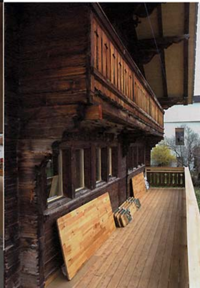
La galerie couverte originelle en façade ouest a laissé la place à une vaste terrasse communiquant avec le living par une baie vitrée ouvrante de trois mètres sur deux. Le balcon de la façade nord a été conservé en remplaçant simplement les éléments pourris.
